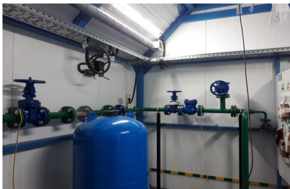
Разводка и подключение инженерных коммуникаций
