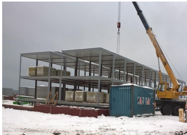
Собранный каркас здания из блок-модулей
