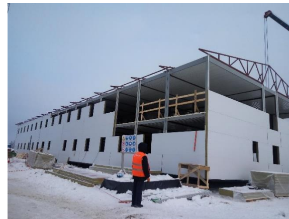
Обшивка каркаса трехслойными сэндвич-панелями
